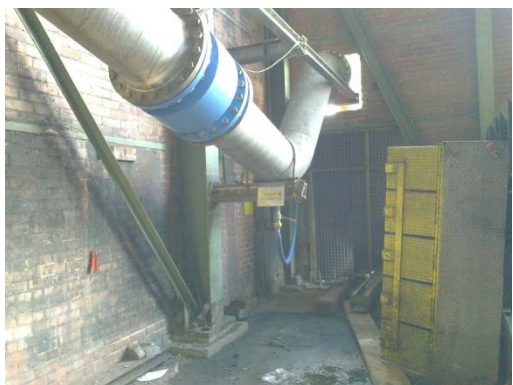
Abbildung 51: Grubenwassermessstelle und Einleitung Zeche Haus Aden, Fotos LANUV und RAG (Einleitung)
