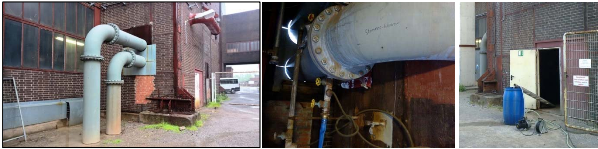
Abbildung 39: Grubenwassermessstellen und Zentrifugenprobenahme Zeche Zollverein, Foto LANUV
