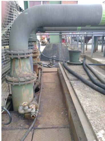
Abbildung 47: Grubenwassermessstelle und Einleitung Zeche Carolinenglück, Foto links LANUV, rechts RAG
