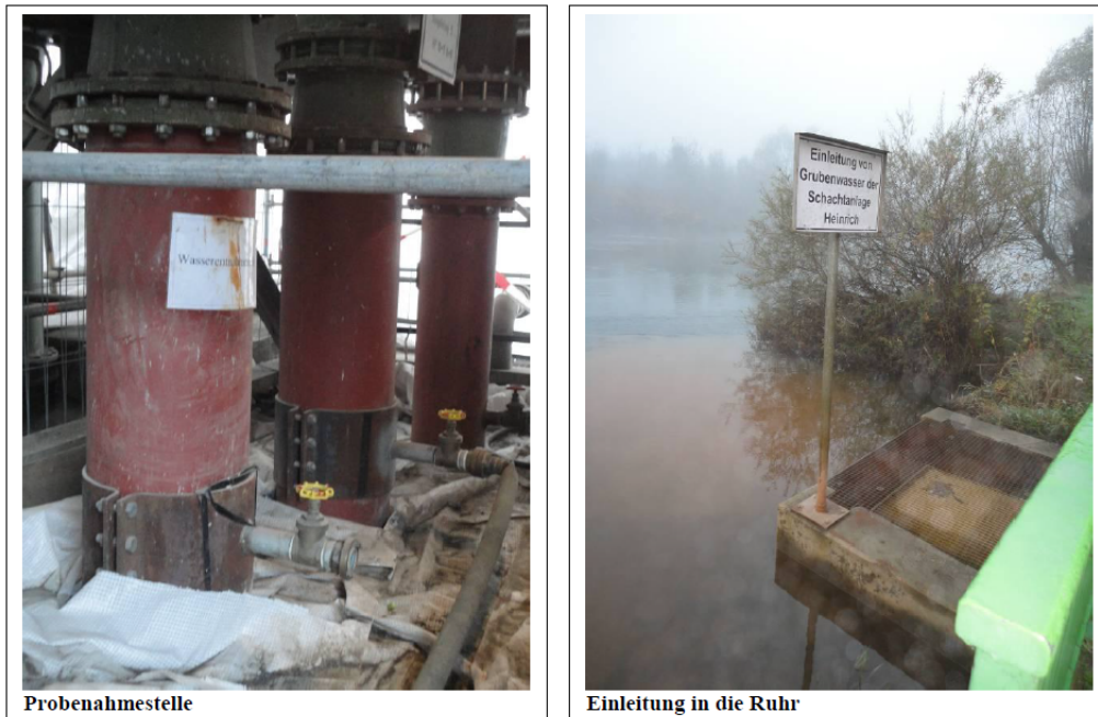
Abbildung 61: Grubenwassermessstelle und Einleitung Zeche Heinrich, Foto RAG
